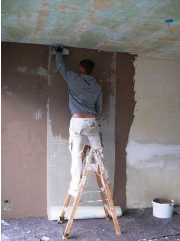
Auftrag, Armierung und Glättung des Unterputzes.
