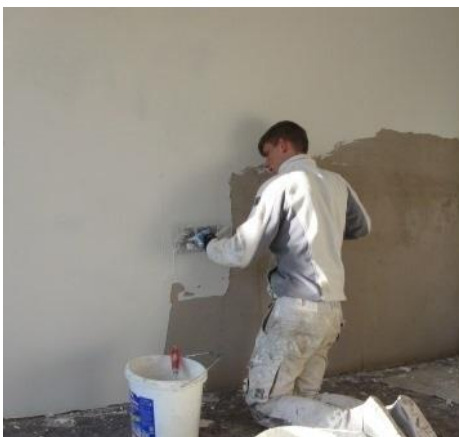
Auftrag des Oberputzes, Putzerggebnis und nach der Verkieselung - hier Cognac. Fertig!
