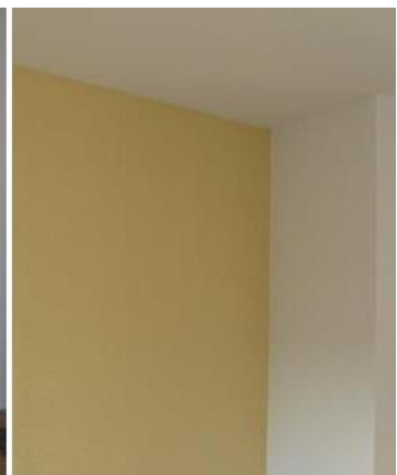
Auftrag des Oberputzes, Putzerggebnis und nach der Verkieselung - hier Cognac. Fertig!
